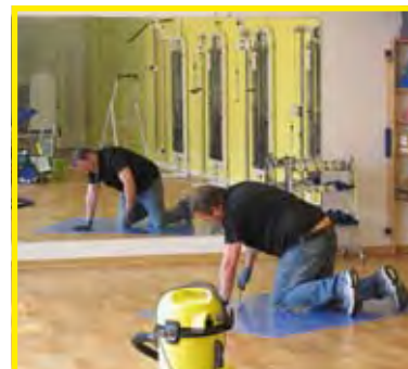
Immer wieder gibt es Neuerungen. Hier installiert Haushandwerker Sven Bergk Plexiglas zum Schutz der Wände.
