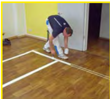
20 Jahre Garantie geben die Maler der Fa. Kipp auf ihre mit Hand und Pinsel aufgetragenen Spielfeldbegrenzungen.
